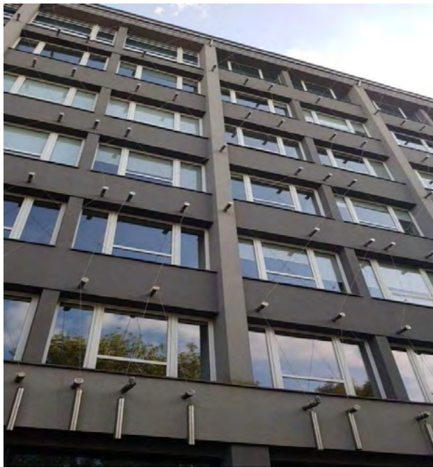
Рис. 2. Закріплені допоміжні троси на фасаді будинку
