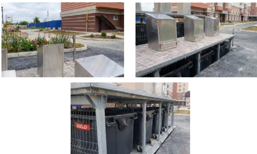
Рис. 2. Приймальні модулі підземної системи збору ТПВ у районі «Греків ліс» (м. Умань) у різних положеннях (опущеному, частково піднятому та піднятому)
